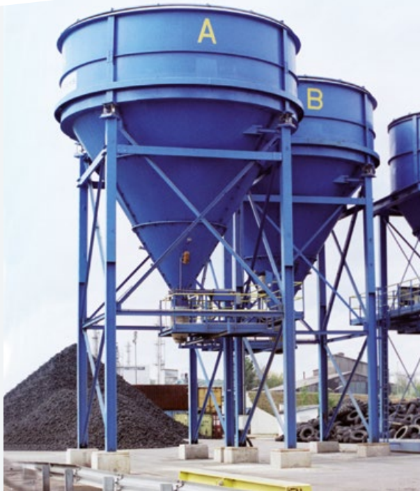
Umschlagsiloanlage in einem Donauhafen
