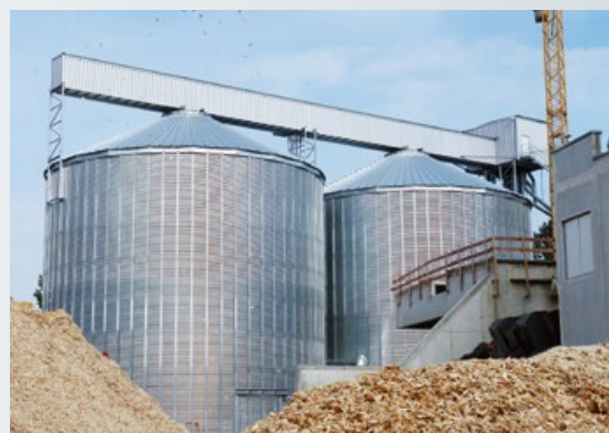
Pelletslager und -umschlagsilos mit Befüll- und Verladetechnik
