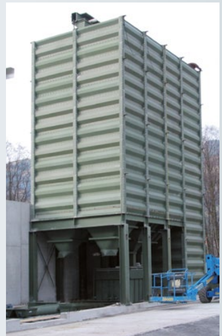
Siloanlage für Getreide
