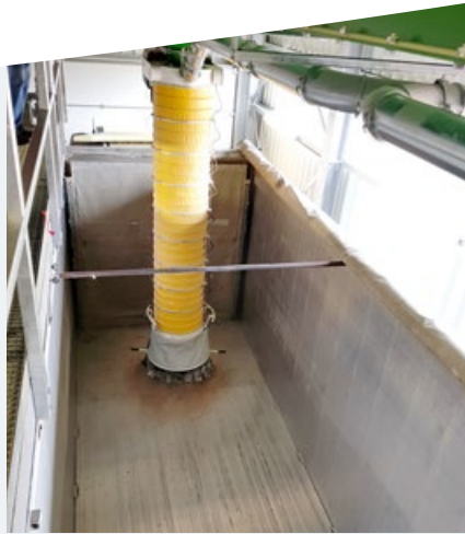
Staubarme Verladung des ausgesiebten Feinmaterials
