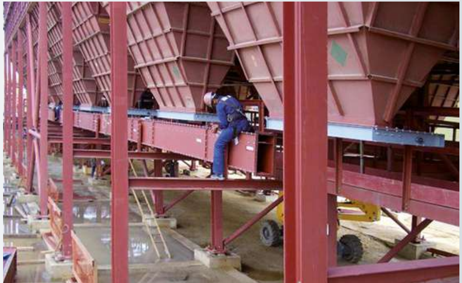
Montage eines Trogkettenförderers in einer Filterentstaubungsanlage
