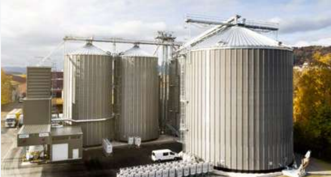
9.000 t Pelletslager mit einem Annahme- und zwei Verladeterminals
