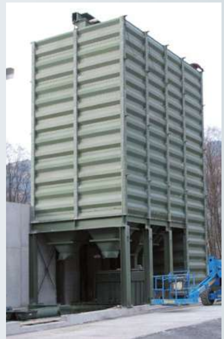
Siloanlage für Getreide
